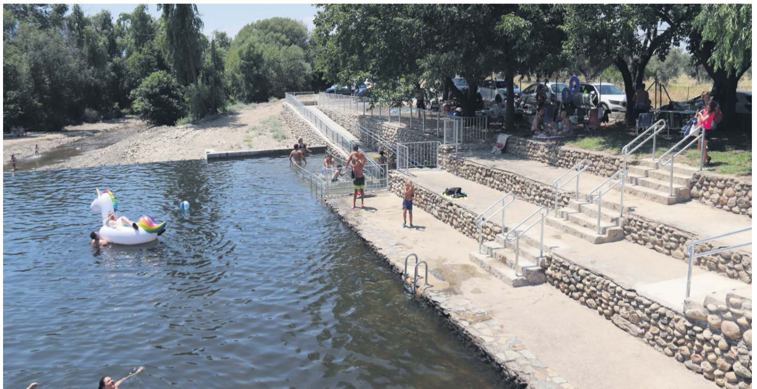
La remodelación de la zona de baño hace que los usuarios tengan mejores accesos a la balsa de agua.
