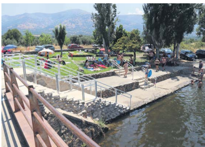
La instalaciones de accesibilidad son totales en el espacio.
