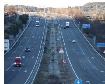
El tramo en malas condiciones.
