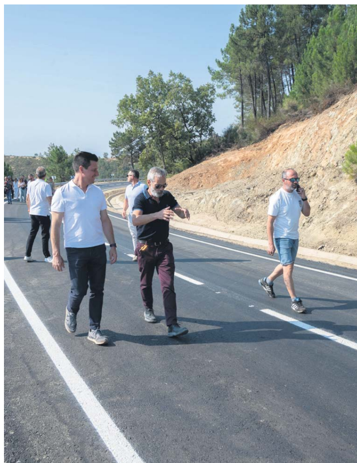
Diputación reforma el socavón de las aguas invernales.
