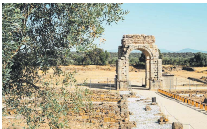
Vista del arco totalmente limpio y rehabilitado.
