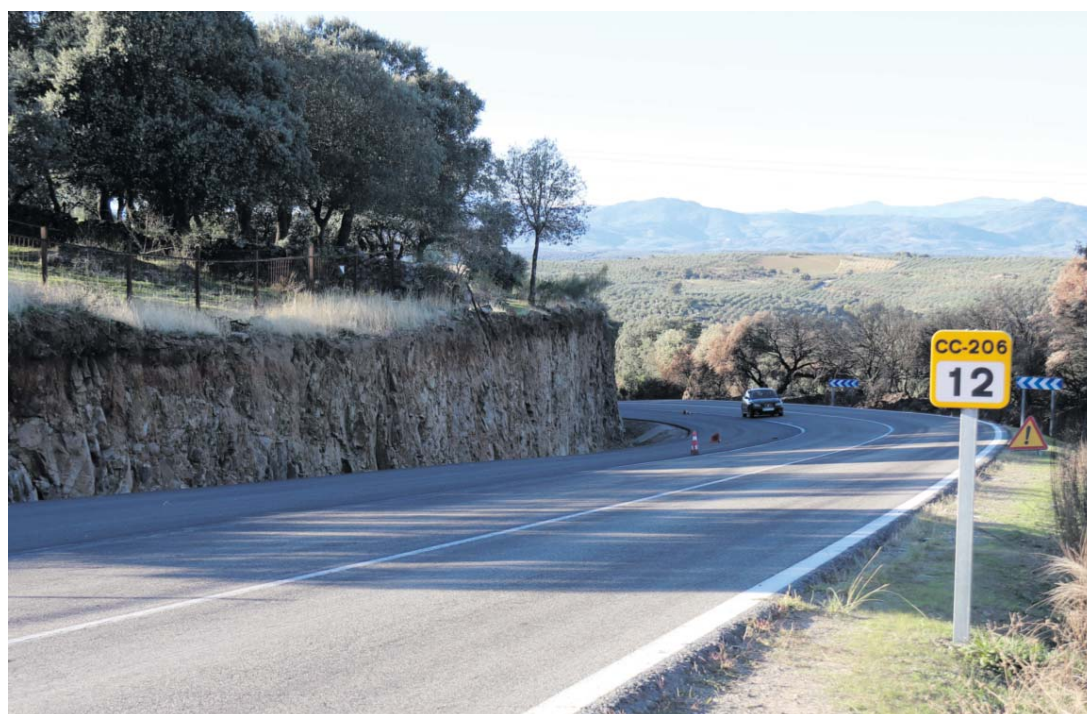
El nuevo carril de vehículos lentos, en Santo Domingo, mejora la circulación.
